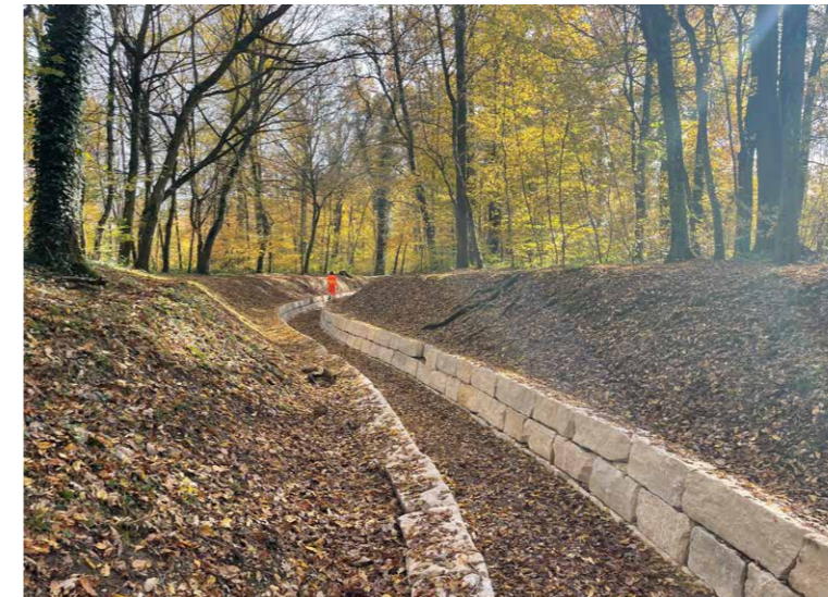
Graben mit neuen Stützmauern aus Kalksteinen
