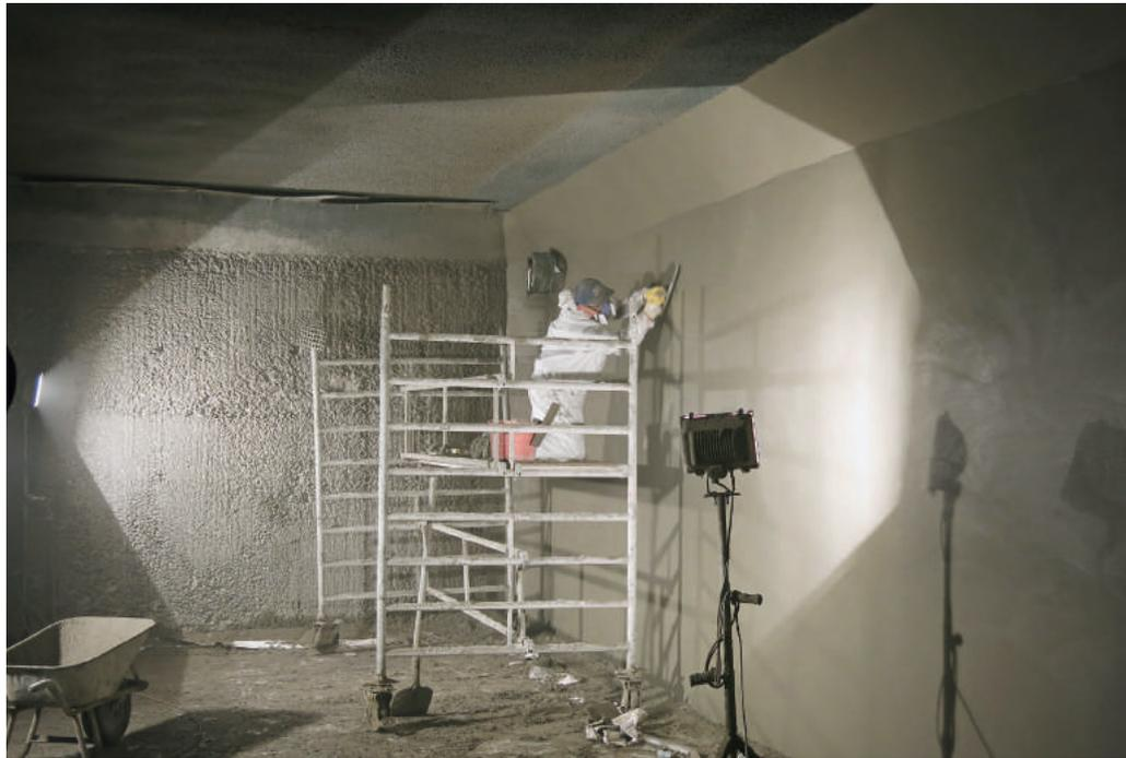
Der frisch aufgespritzte Spezialmörtel wird mit der Traufel von Hand geglättet
