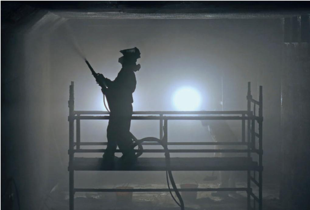
Der Operator an der Spritzdüse beim gleichmässigen Auftragen des Spritzmörtels
