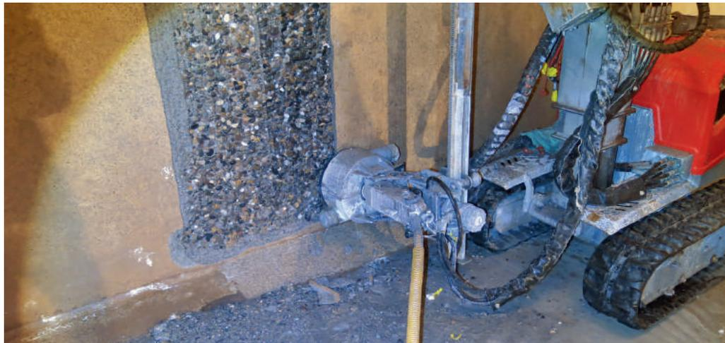
Die alte, aufgeweichte Mörtelschicht wird mit rotierendem Hochdruckwasserstrahl «abgefräst»
