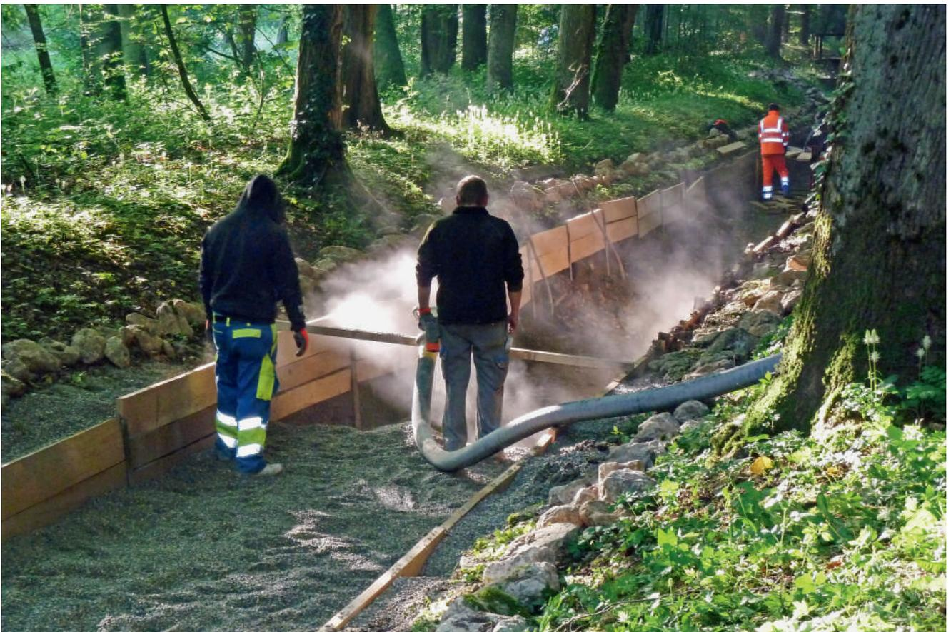
Frischer Filterkies wird in den vorbereiteten Sickergraben A eingeblasen
