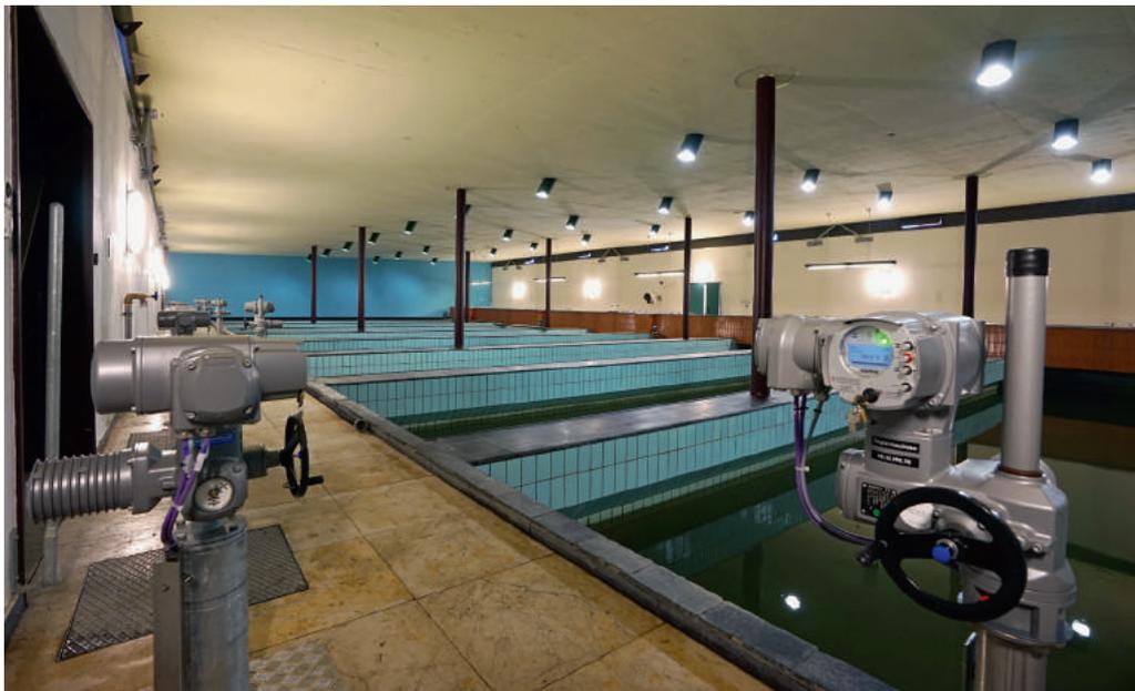
Die Filterhalle des Schnellfilters 1 mit neuen Armaturen und Elektroantrieben
