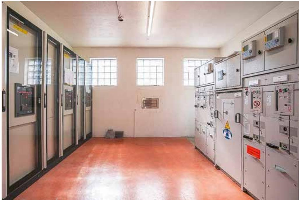
Die Niederspannungshauptverteilung links und rechts die Mittelspannungsschaltanlagen, wo bei Bedarf 13'400 Volt geschaltet wird
