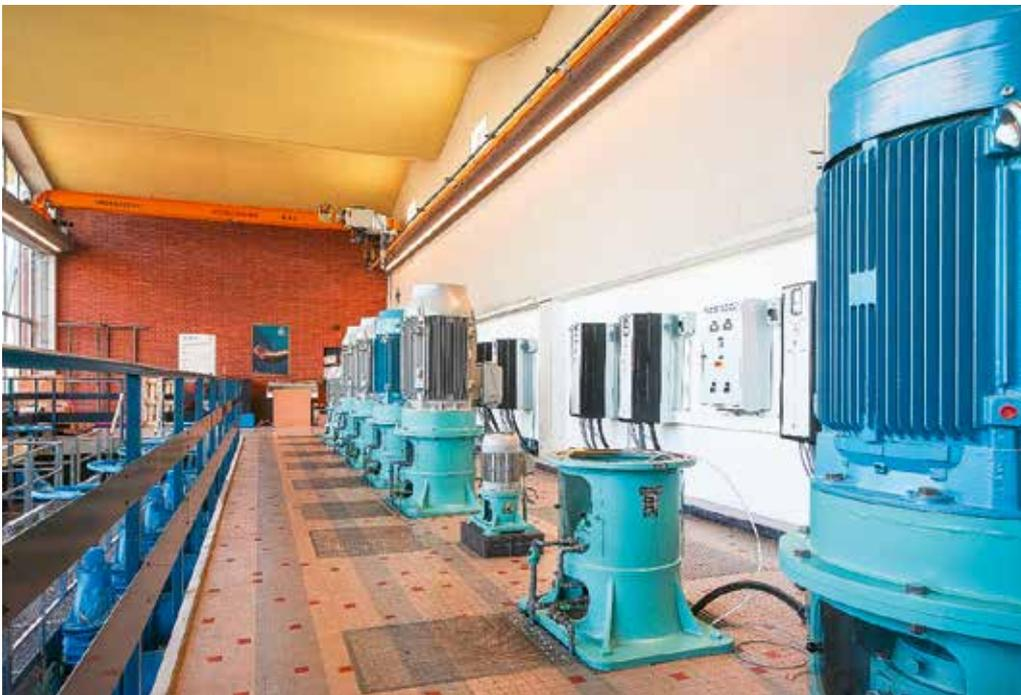
Die Filtratpumpen sind mit hocheffizienten IE4 Normmotoren bestückt und werden über Frequenzumformer drehzahlgesteuert
