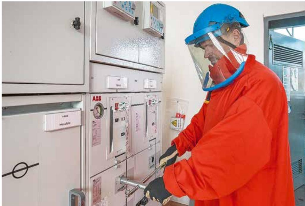
Betriebslektriker Roman Pernter bedient als instruierte Fachperson die Mittelspannungsschaltanlage, dazu ist das Tragen der persönlichen Schutzausrüstung obligatorisch
