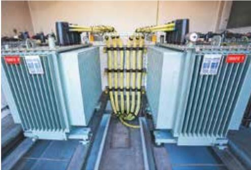
Zwei unabhängige 13 kV Mittelspannungstrafos sorgen für einen sicheren Betrieb der Hardwasser-Anlagen
