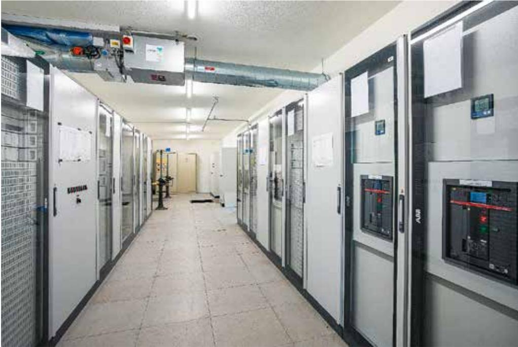
Die beiden neuen Niederspannungs-Unterverteilungen mit einer Betriebsspannung von 400/230 Volt
