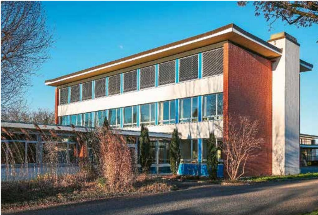
An der Fassade des Verwaltungsgebäudes wurden die blauen Paneele ausgetauscht und darunter eine Wärmedämmung verbaut
