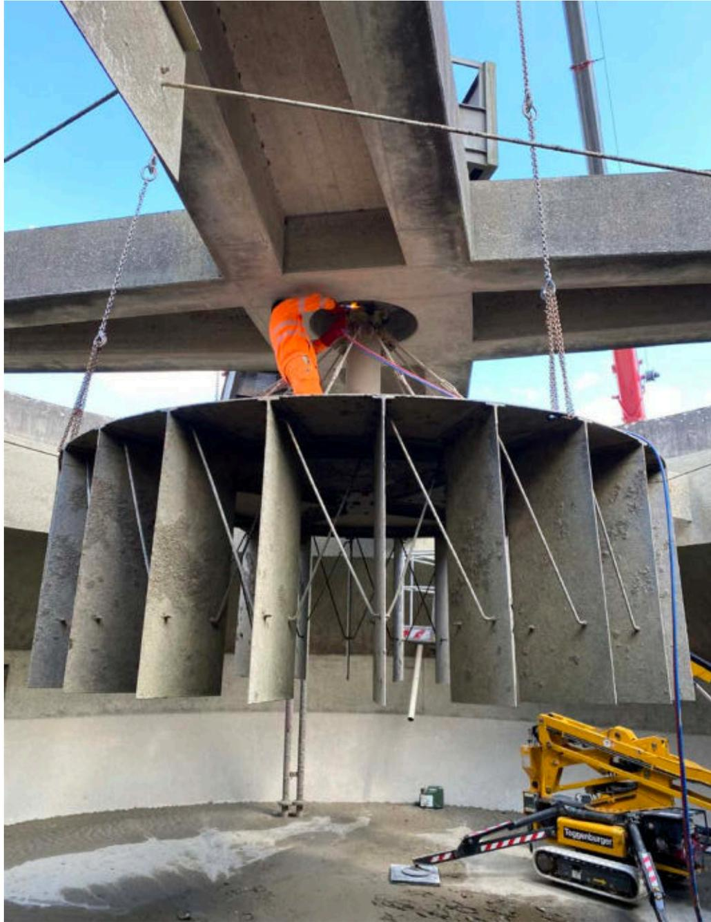
Remontage des revidierten Cyclator-Rührwerkgetriebes
