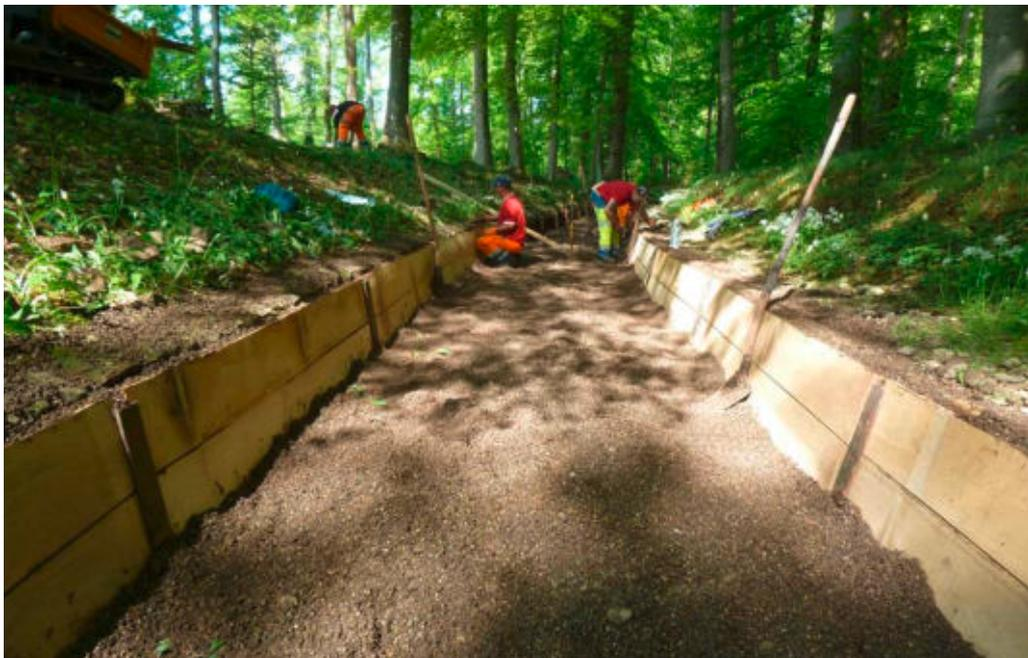
Graben D: Befestigungsarbeiten der Grabenverbauung
